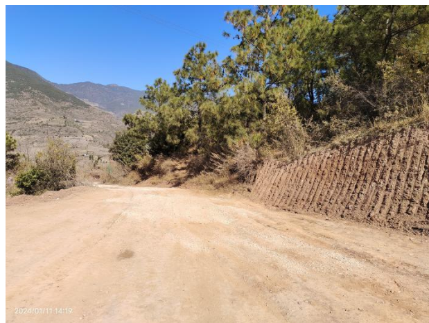
厂区矿运道路
