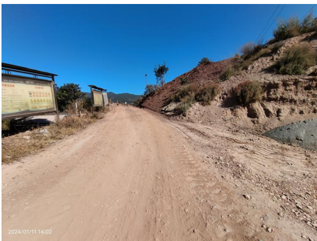
厂区矿运道路
