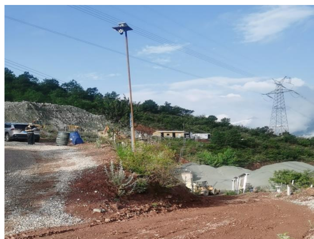
厂区入口及视频监控
