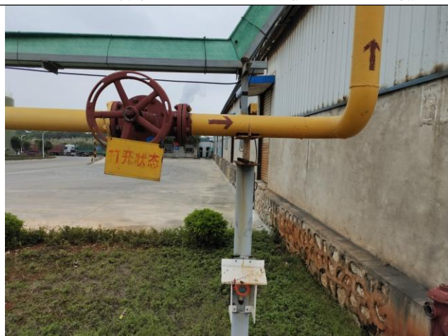
照片 4 氯气总管上的切断阀和气体报警器
