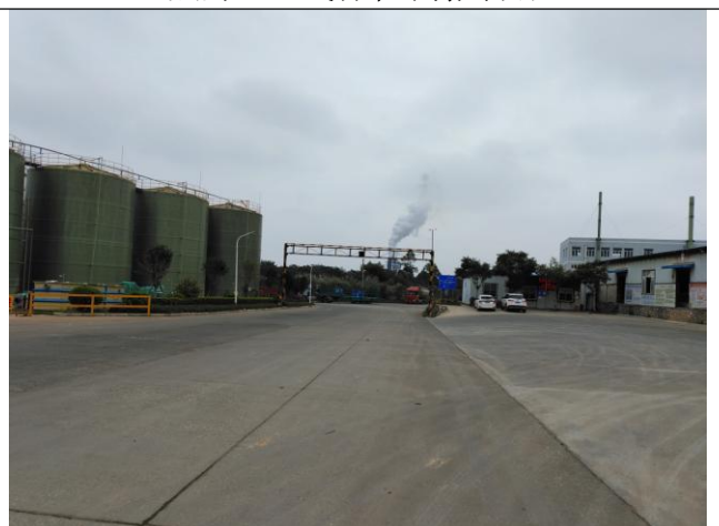
照片 22 厂区东面情况
