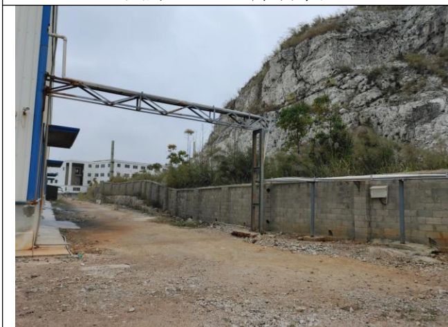
照片 23 厂区西面山坡
